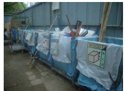
現場でのゴミ分別場
