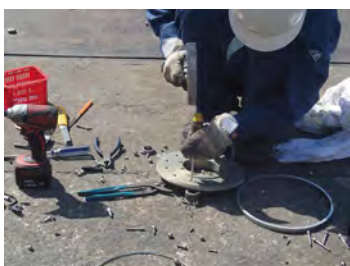
手作業による解体・分別
