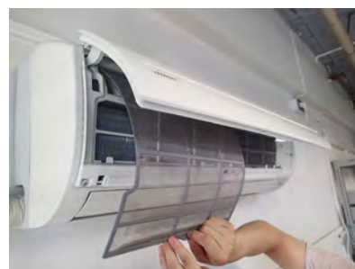
エアコンフィルター清掃の様子
