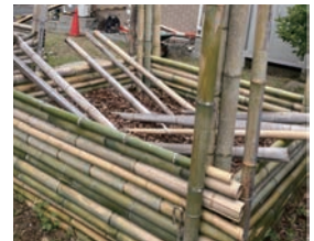
堆肥ピットの様子
