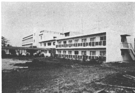
完成後の留学生部寮
