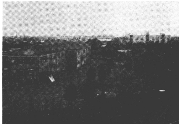
旧5号館の全景
