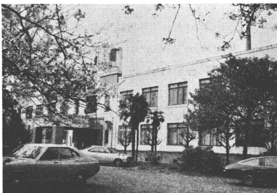
整形外科・放射線科の建物 (古くは附属病院別館と言われた)
