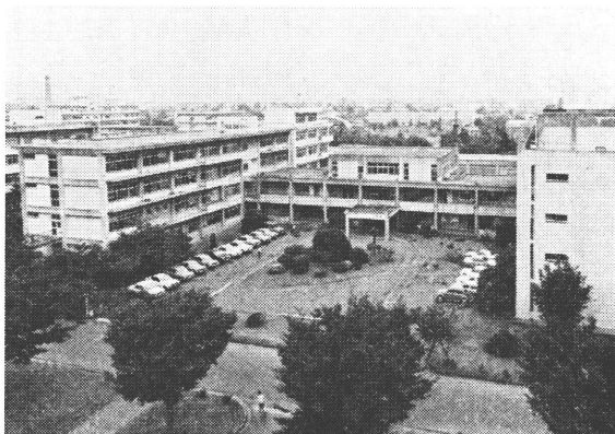
工学部本館正面
