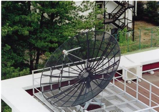
写真 2 12 7 4 GMS (気象衛星ひまわり) のアンテナ
