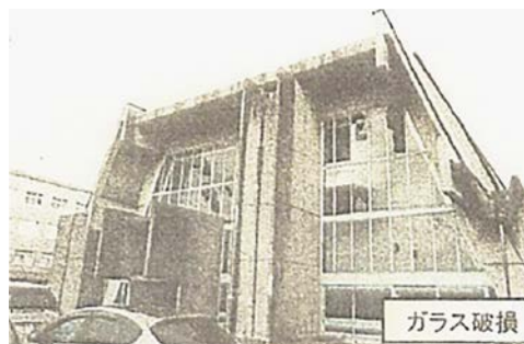
図1-6-1-1 ガラスが破損落下した医学部記念講堂（「23.4.28経営協議会資料」）
