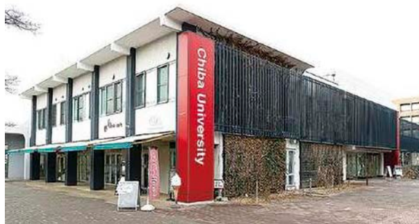
写真1-8-1-1 総合学生支援センター棟
