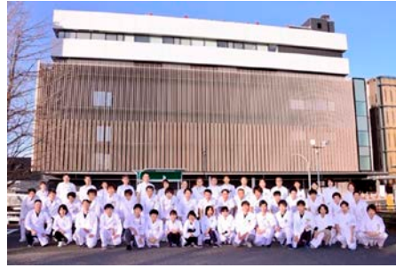
写真2-9-1-6 2021年1月新中央診療棟完成
