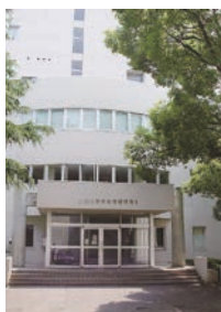
自然科学系総合研究棟1 Science and Technology Building I
