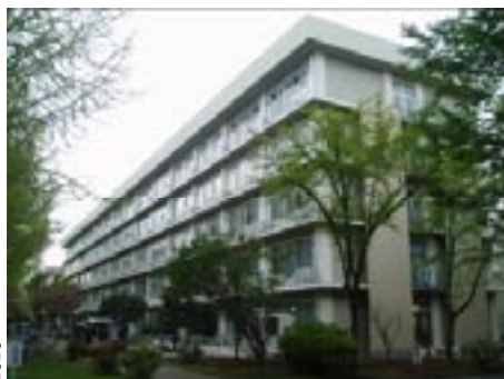
写真左 総合校舎A号館 写真右 理学部4号館
