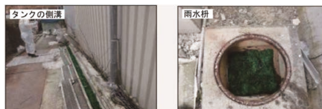
図2：セシウム除去用吸着繊維のタンクの側溝および雨水枡への設置
