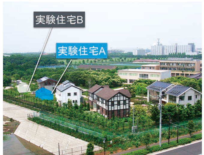
新実証実験棟：違う建材、構法を使用して建設予定
